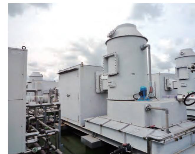
総合研究所の排気洗浄塔
