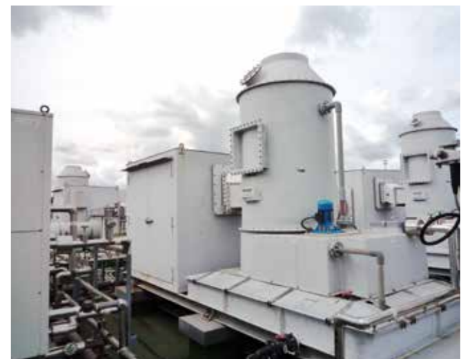
総合研究所の排気洗浄塔
